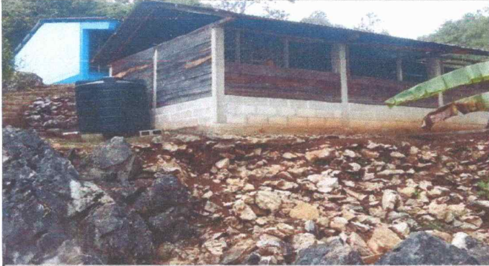
Foto 1: Sustrucion con dos puertas y ventas de las aulas
