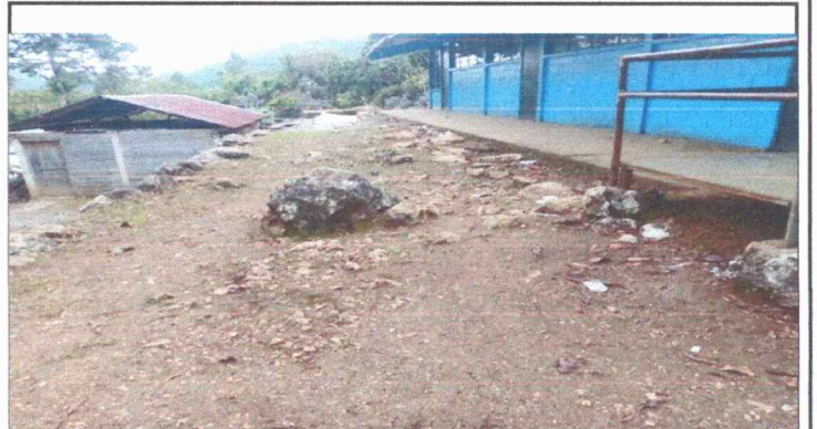
Foto 4: Culminacion de muro de contencion
