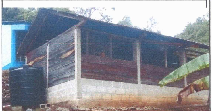
Foto 2: Sustrucion cubierta de laminas y estructuras de techo
